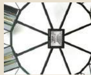
Éclairage central (ECC)
